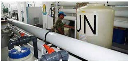
Imagem 11: Os equipamentos de purificação de água ideais são os de osmose reversa Fonte: BRASIL. Exército Brasileiro. BRAENGCY trata e distribui água regularmente no Haiti. Disponível em: < http://www.eb.mil.br/web/haiti/inicio?p_p_id=56&p_p_lifecycle=0&p_p_state=maximized&p_p_mode=view&p_p_col_id=118_INSTANCE_9vawgekUpPVA__column-1&p_p_col_pos=1&p_p_col_count=2&_56_groupId=112951&_56_articleId=5914147#.XQgE52f-rpl >. Acesso em: 14 jul. 2018.
